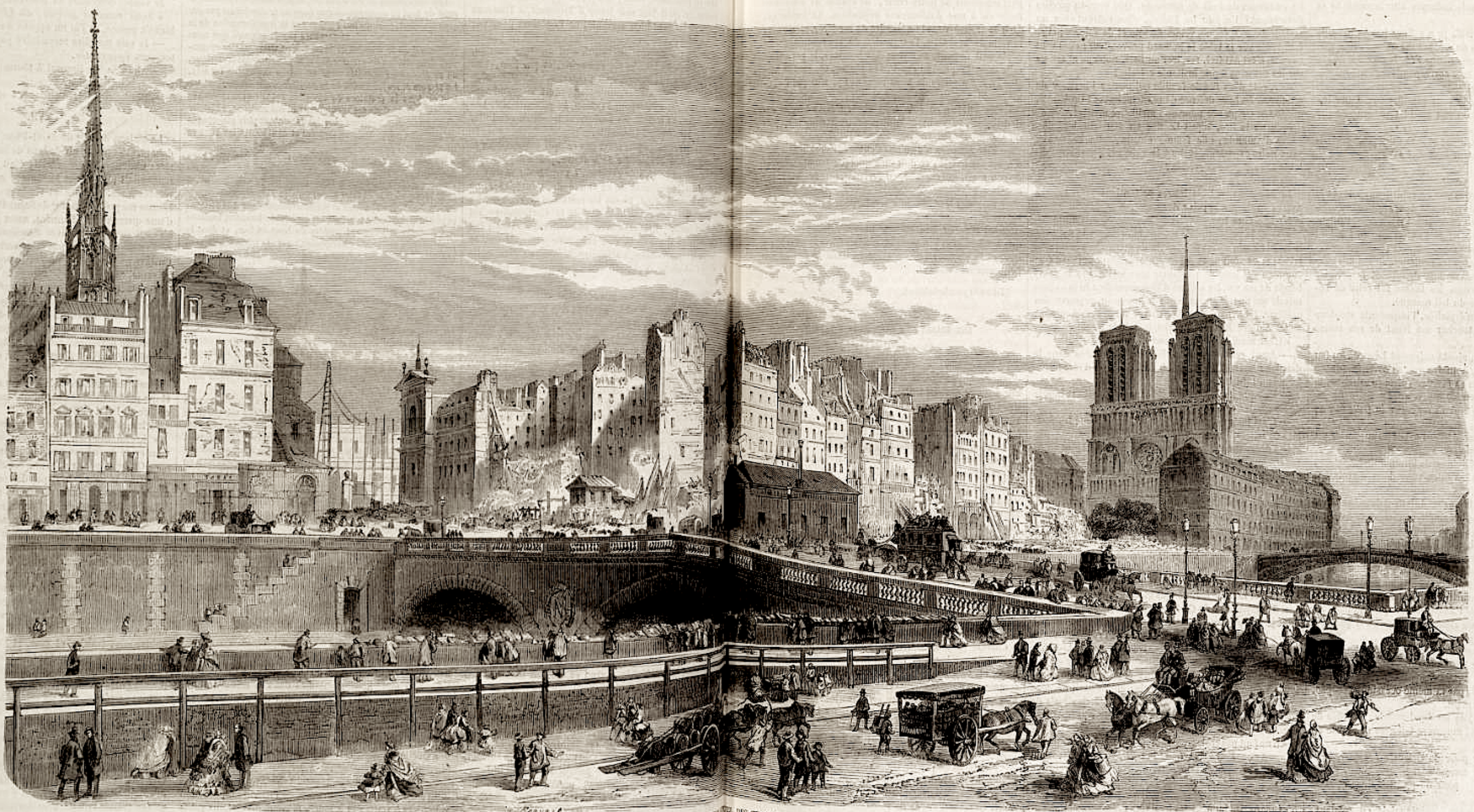
DÉMOLITIONS DE LA CITÉ - ASPECT DES TRAVAUX. (Voir la page précédente.)
